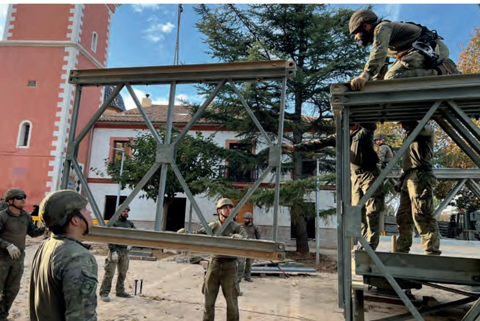
Montaje del puente *Mabey* instalado por el Ejército de Tierra en Picanya. Debajo, la UME limpia un barranco a mano mientras dos helicópteros *EC-135* del BHELEME realizan una inspección aérea.
