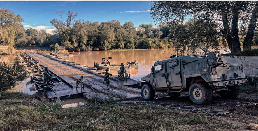
Puente fijo flotante MAN, levantado sobre el Ebro, desde una ribera a la otra, para permitir el paso continuo de vehículos y personal.
