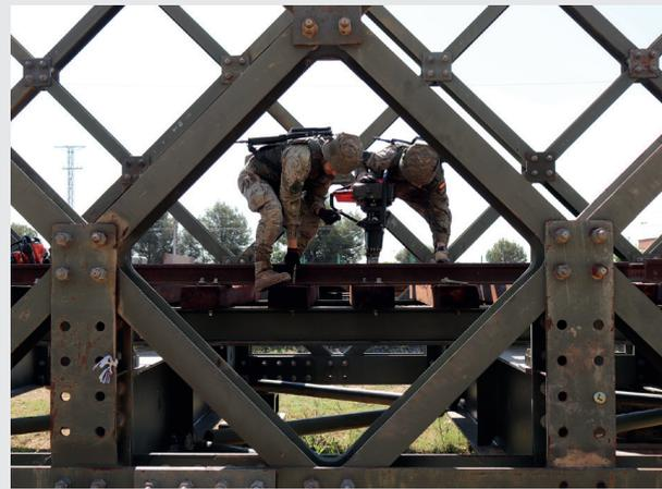
Montaje de un puente Mabey en el acuartelamiento Sangenis a cargo de la compañía de Puentes sobre Apoyos Fijos.
